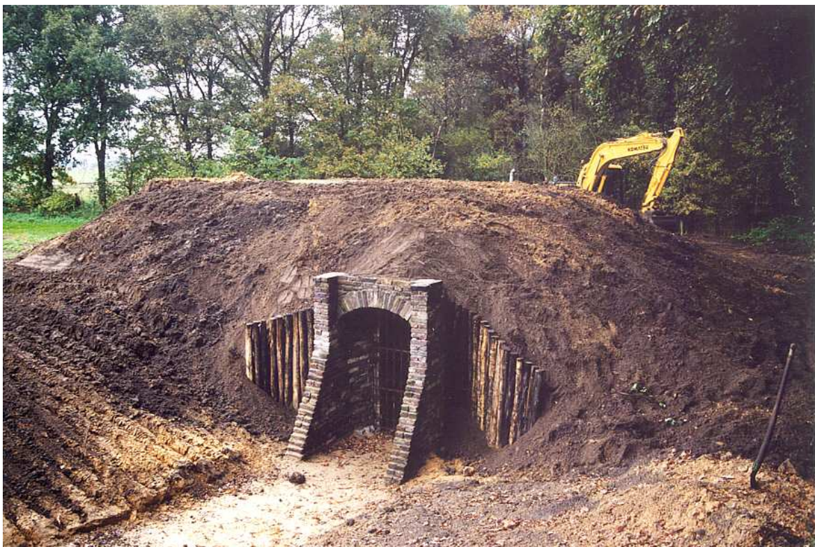
De bouw is grotendeels gereed. Er wordt een flinke laag zand overheen gebracht. Zie voor het eindresultaat de foto op de voorpagina. Foto: Roel Winters.
