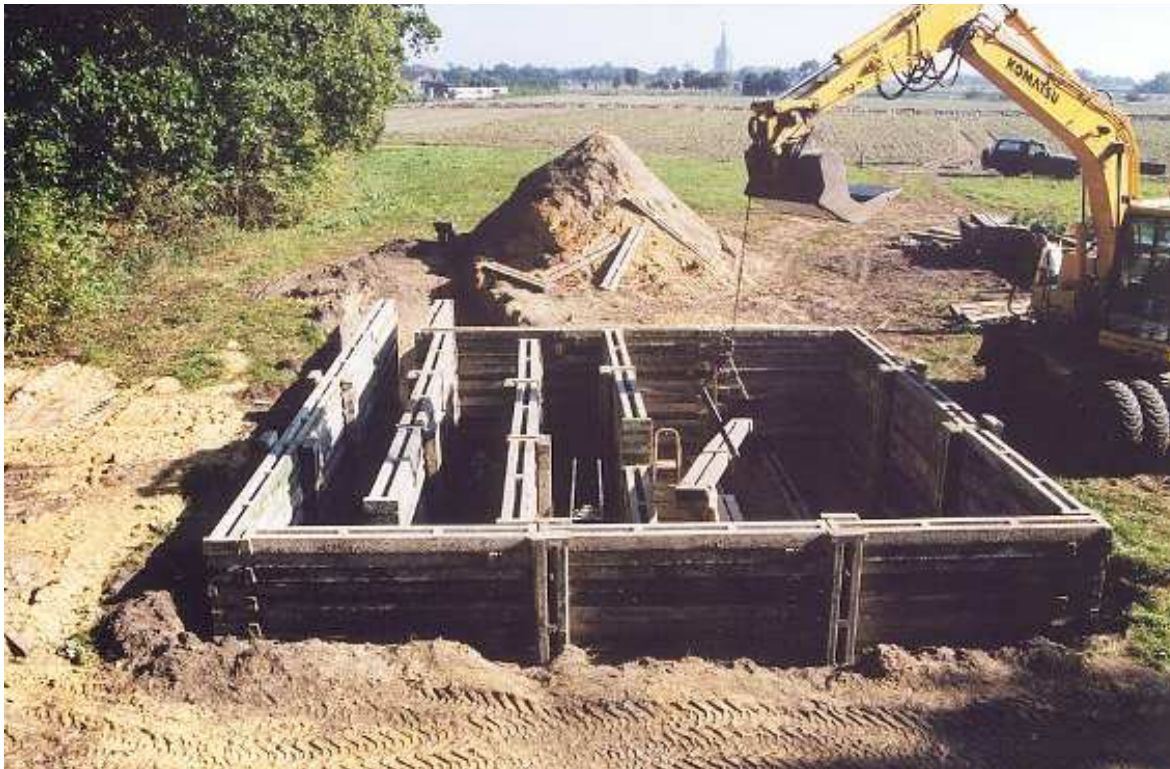
Een kelder in aanbouw. De vloer ligt onder het maaiveld, voor de stabiliteit en vochtigheid. Door de zigzag indeling ontstaat een lange gang. Foto: Roel Winters.
